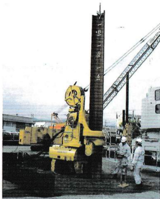
设置U型钢板桩的情况
