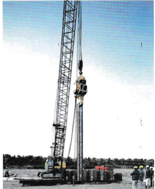
设置U型钢板桩的情况
