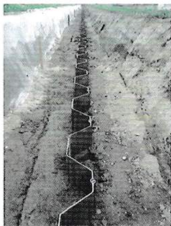
使用了帽型钢板桩900(10H)的示范施工现场
